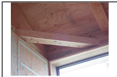
コメント 火打ち材設置
