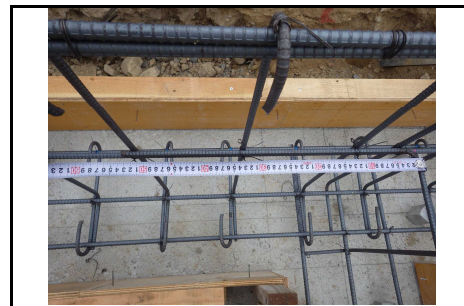
コメント 補強筋と主筋の緊結状況
