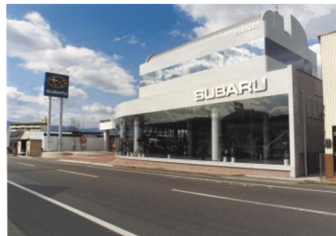
徳島市 SUBARU 金属パネルや面の一体感を使用して建物を工業製品のように見せる、一方見た目に柔らかさも必要と考え曲線を用いている
