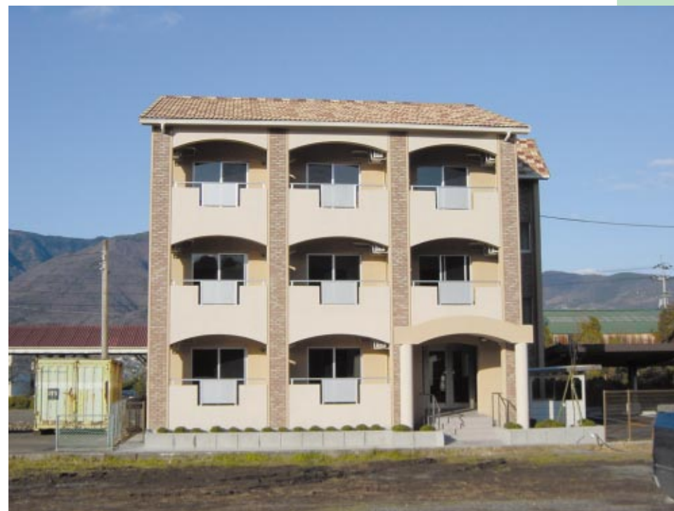
共同住宅 ワンルームタイプの共同住宅です。
